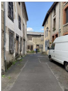
vue façade SUD rue Saint-Michel
