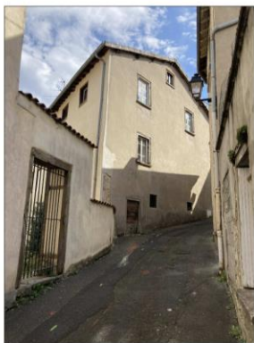
vue façade OUEST rue Saint-Michel
