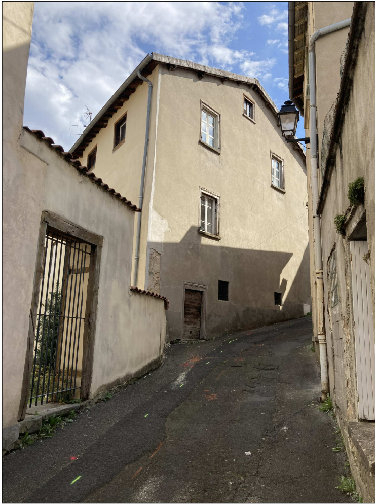
vue façade OUEST rue Saint-Michel
