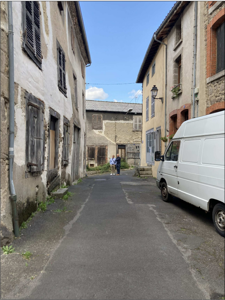
vue façade SUD rue Saint-Michel
