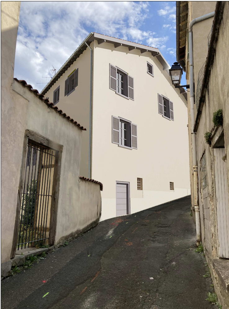
vue façade OUEST rue Saint-Michel
