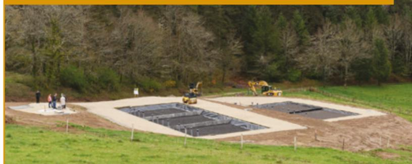
Mise en place d'un système collectif de collecte et traitement des eaux usées.
